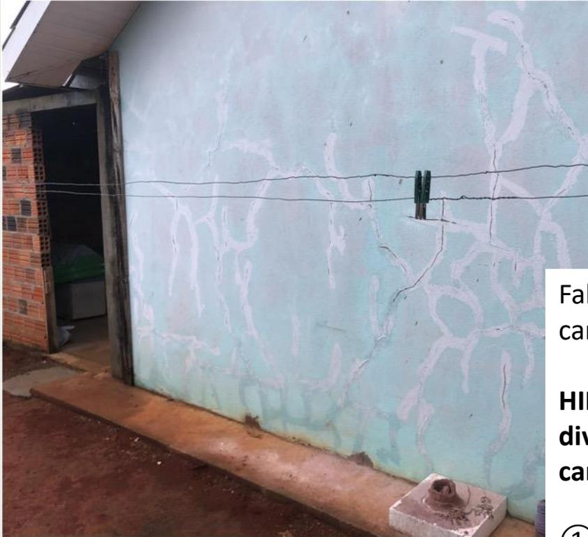
Falha / Vício: **Formações de *fissuras mapeadas*** (ABNT NBR 7200) no revestimento externo, caracterizadas **pela retração da argamassa**
